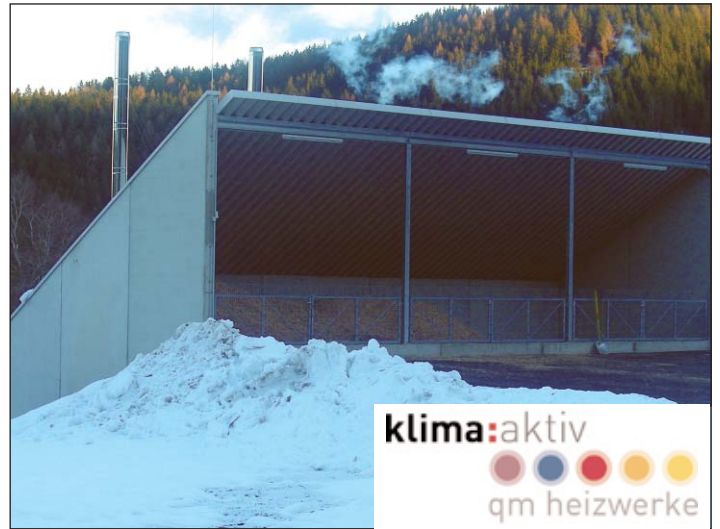
Die neue Heizzentrale der Firma Waldkraft GmbH am Areal des Sägewerks Wrodnigg in Kraig.
